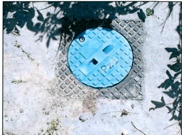
Nouvelle bouche à clé mise en place au droit du piézomètre Pz1
